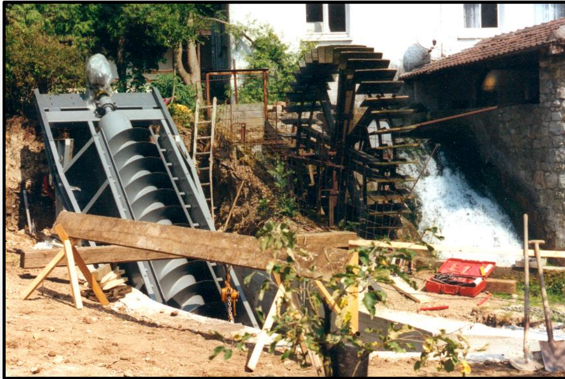
Ausgeführte Schnecken-turbinen für den Einsatz in Flüssen und Bächen
